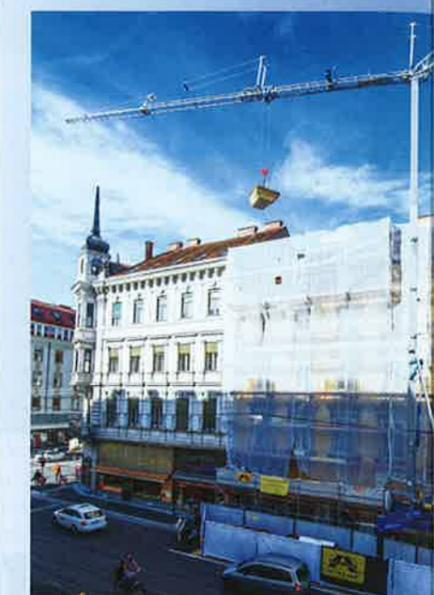
Neben Condicta Kranen führen wir Clever Krane mit einer 25,6 m und einer Hakenhöhe bis 29,5 m. Der Kran mit teleskopischen Stützen und einer selbstfahrenden hydraulischen Verfahrweise.
